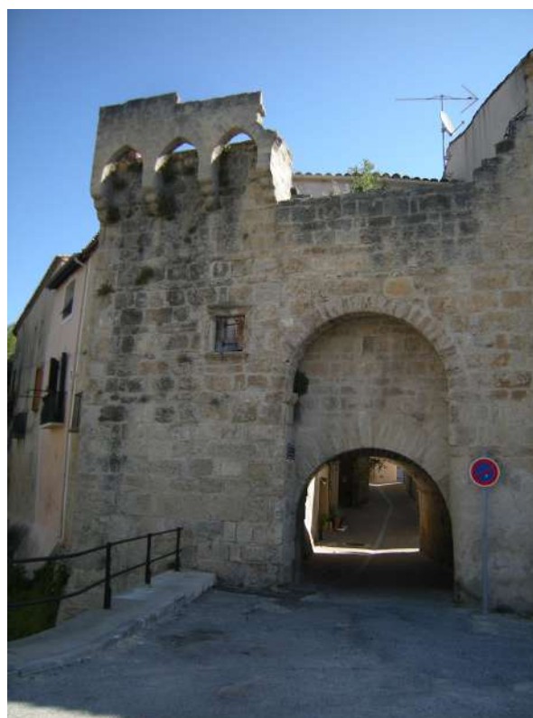
Porte et remparts du 14e siècle
